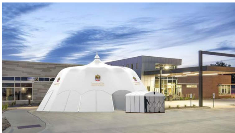
建物前設置例
